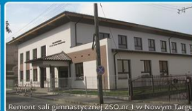
Remont sali gimnastycznej ZSO nr 1 w Nowym Targu
