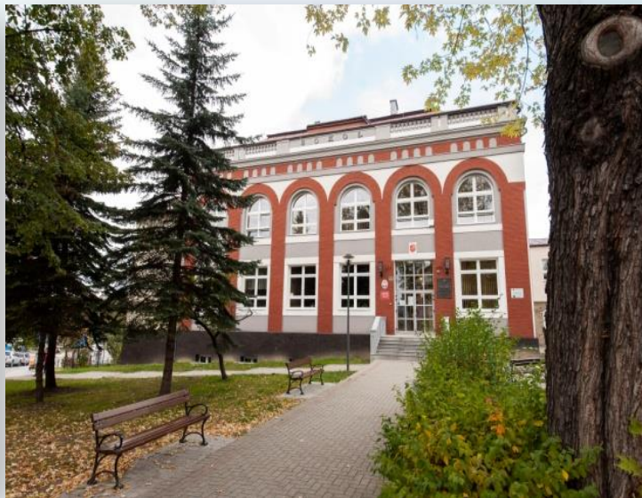
Termomodernizacja ZS Nr 1 w Nowym Targu
