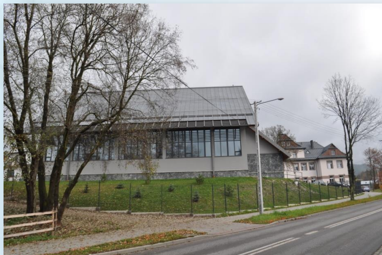
Sala gimnastyczna przy ZSE Nowym Targu
