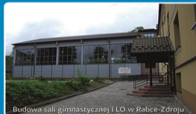
Budowa sali gimnastycznej (LO w Rabce-Zdrój)
