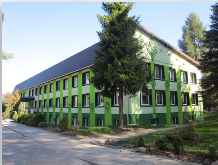
Termomodernizacja SOSW Nr 1 w Nowym Targu
