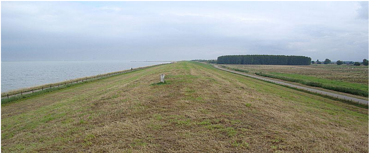
Abb.39 Seedeich an der Nordsee
