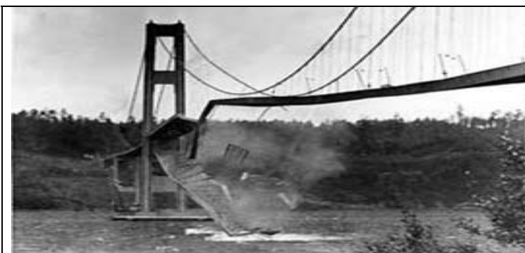
Die Hängebrücke über das Tacoma -Tal im US-Bundesstaat
