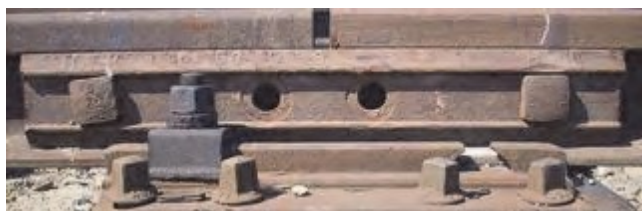
Rys. 10. Łubki skręcone dwiema śrubami
