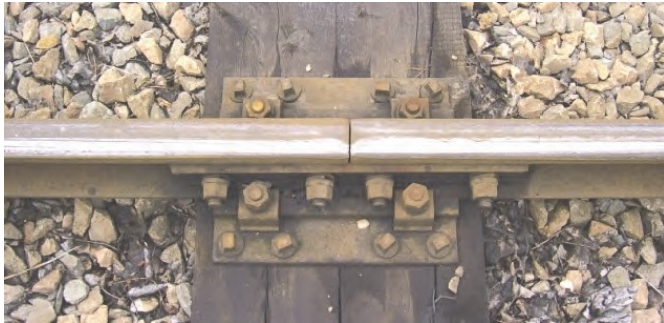
Rys. 11. Złącze szynowe po zakończeniu robót
