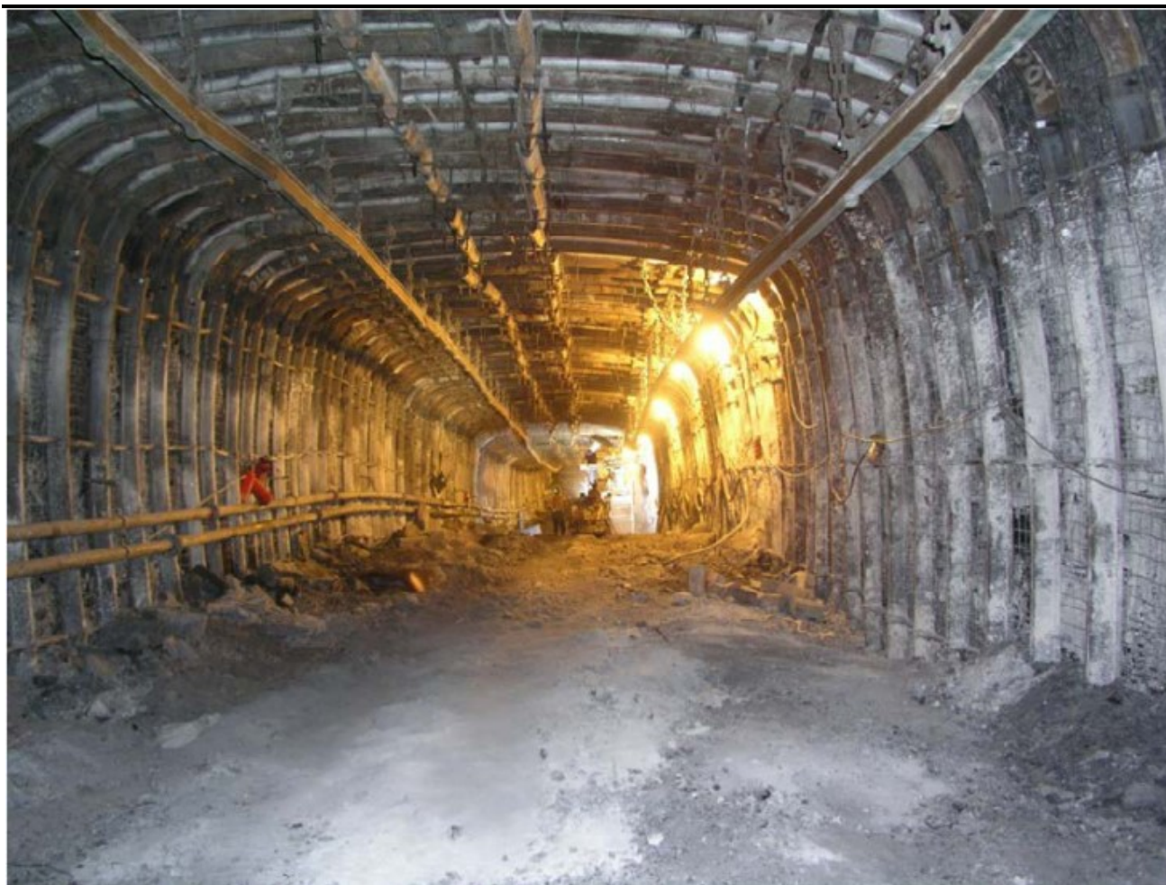
Rys. 7. Przecinka rozruchowa w obudowie ŁPrP w LW Bogdanka (fot. A. Ruchel).
